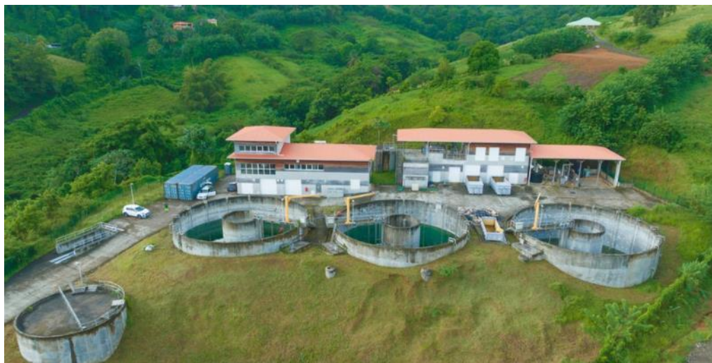
Station de traitement des eaux, Le Robert © France Antilles
