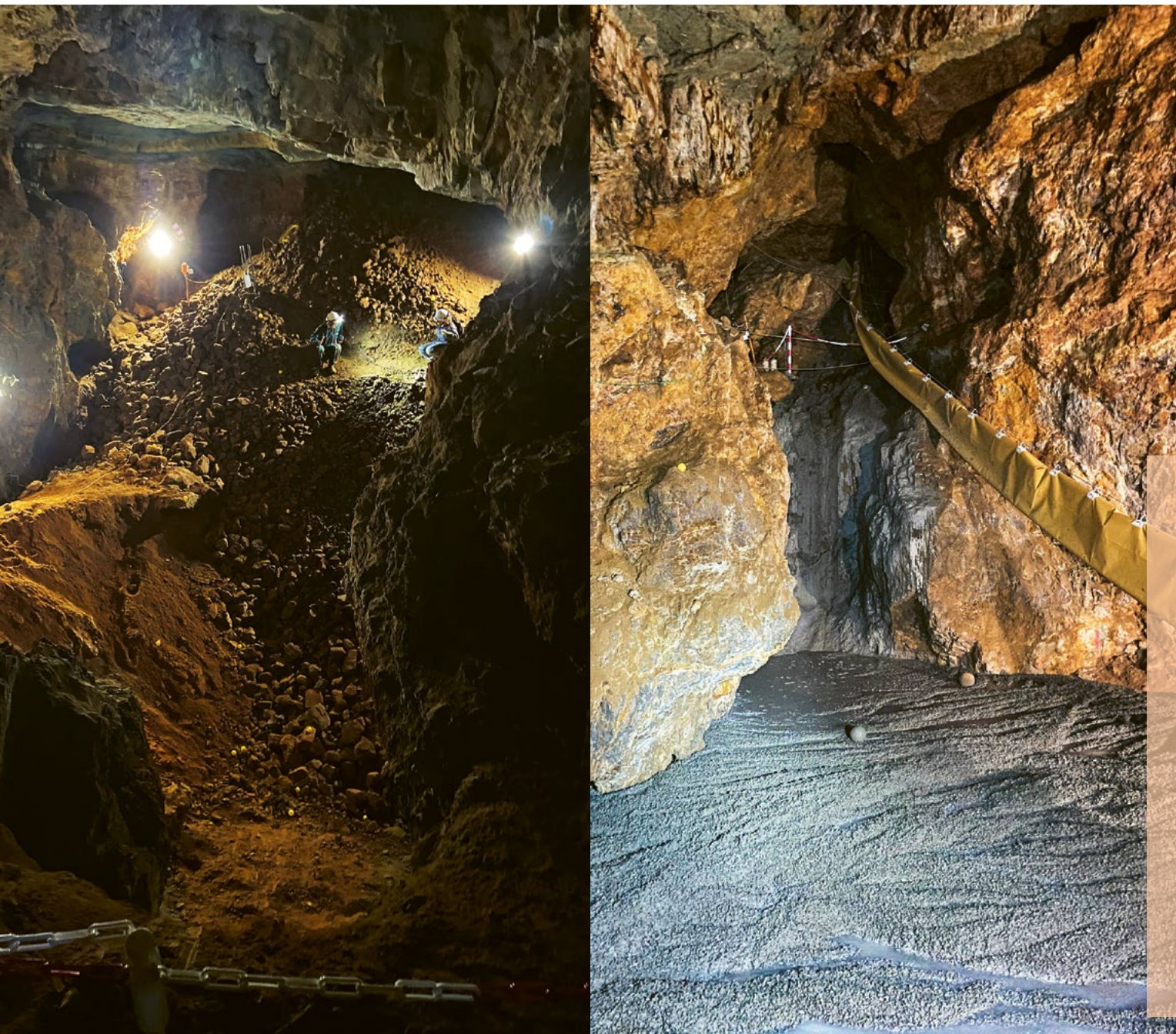
Vue de l'intérieur de la grande salle de la mine du Pradal, avant (à gauche) et pendant (à droite) son comblement par injection de béton. © IGECAV
