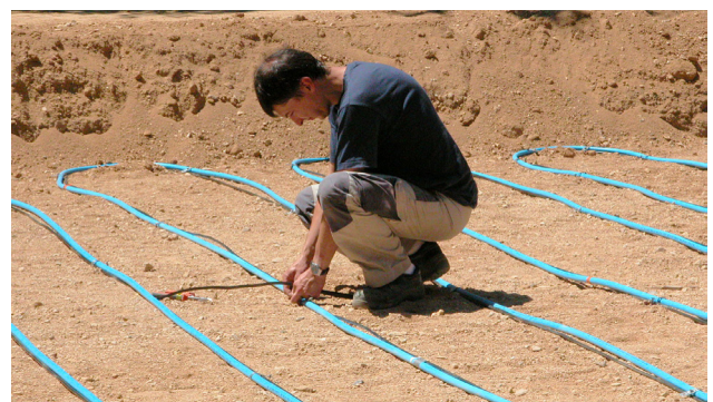
Échangeur horizontal - © BRGM
