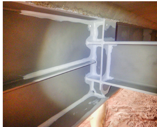
Figure 7 : chantier de décapage d'une surface métallique (par projection d'abrasif).
