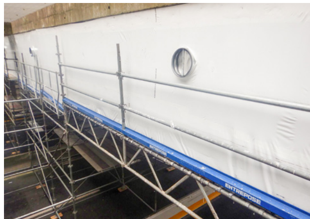
Figure 6 : confinement de la structure métallique pour un chantier de remise en peinture.
