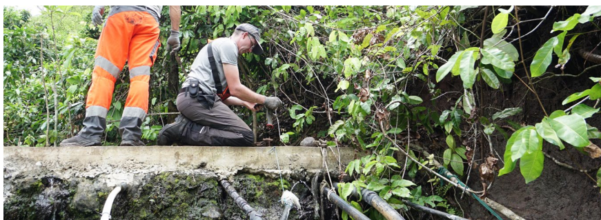
Nettoyage d'un captage en rivière © SOLIDARITES INTERNATIONAL
