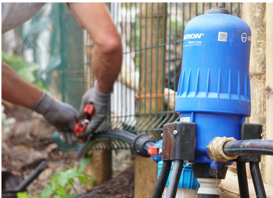
Système de chloration de l'eau Dosatron © SOLIDARITÉS INTERNATIONALES
