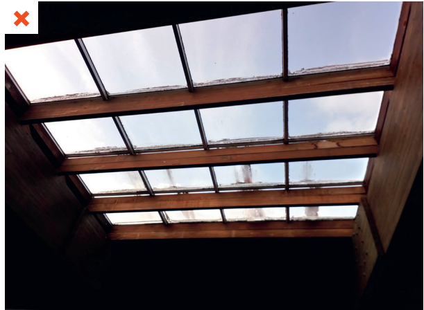
La présence d'une verrière implantée en plafond entraîne un apport trop important de chaleur et de lumière. ©AQC
