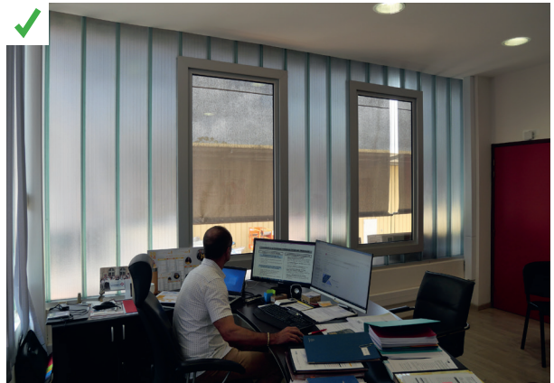
La pose d'un store extérieur a permis de protéger la paroi translucide des apports de chaleur. ©AQC
