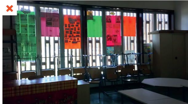
Les protections solaires verticales sont inefficaces en façade est et ouest. Les utilisateurs ont occulté les fenêtres exposées à l'ensoleillement direct. ©AQC
