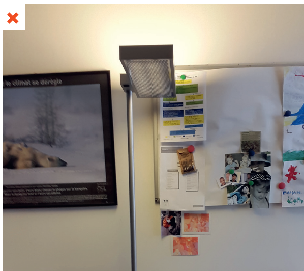
Les luminaires sur pied des bureaux fonctionnent à détecteur de mouvement et s'éteignent au bout de quelques minutes. ©AQC
