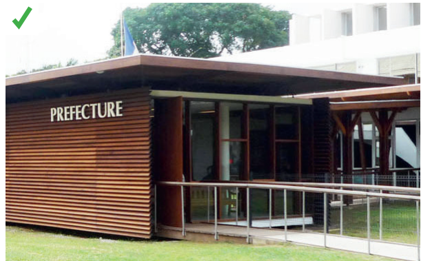
Les fenêtres sont implantées sur les façades nord et sud. Les jalousies en bois fixes sont implantées sur les façades est et ouest pour favoriser la ventilation naturelle. ©AQC
