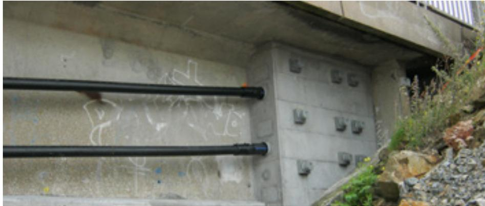
▲ Figure 70 - Ancrage d'about de la poutre témoin et des câbles de précontrainte extérieurs au béton. On peut voir le rajout de béton sur le talon (pont de Saint-Nazaire, entreprise Bouygues).
