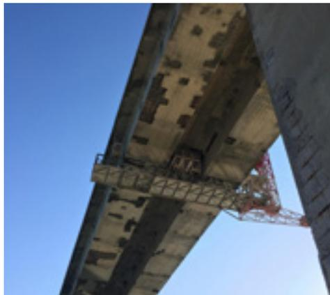
◀ Figure 65 - Purge des bétons dégradés et réparation à l'aide d'une nacelle négative de forte capacité (pont de Noirmoutier, entreprise Freyssinet).
