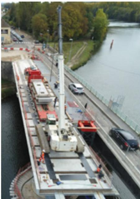
◀ Figure 35 - Une fois la charpente neuve installée, le hourdis neuf est posé par éléments préfabriqués en usine à l'aide d'une grue mobile (chantier de Pont-sur-Yonne, entreprise Vinci Construction France TP Lyon).
