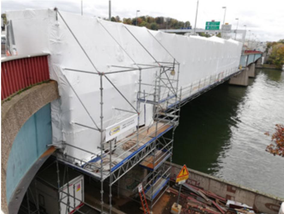
▲ Figure 43 - Un échafaudage revêtu d'une bâche rétractable a permis de réaliser le confinement nécessaire au décapage de la peinture au plomb sur les PRS (pont de Sèvres à Boulogne-Billancourt, entreprise Lassarat).
