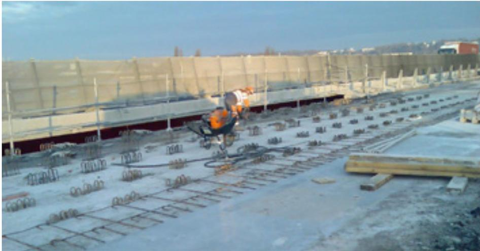
▲ Figure 63 - Après décapage par hydrodémolition, mise en place du ferrailage de la future chape (pont sur l'Adour A63, entreprise Vinci).
