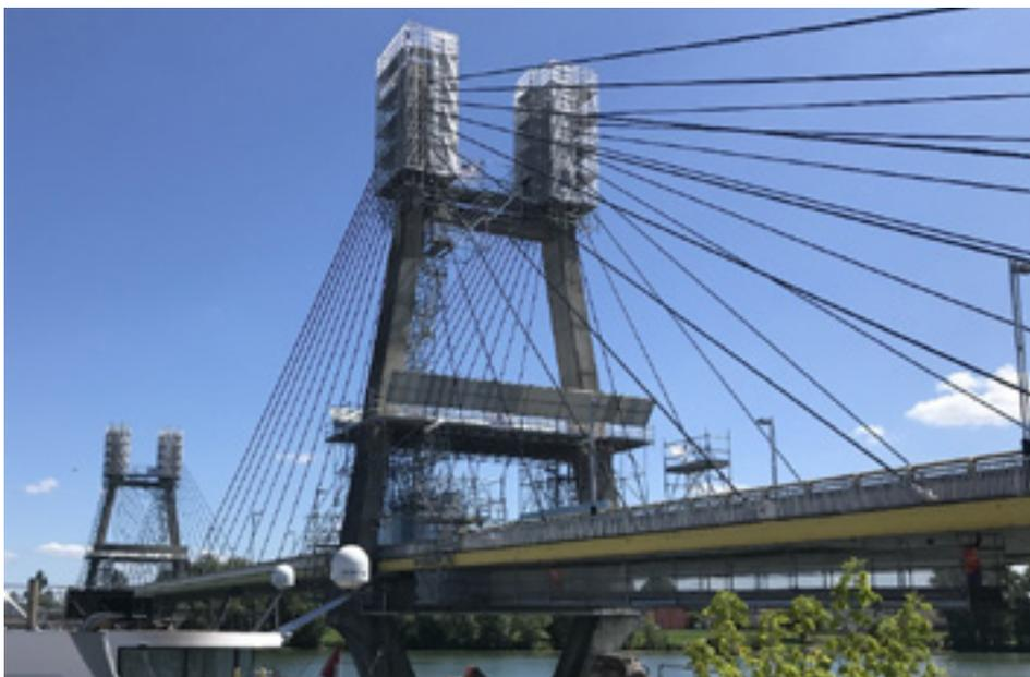
▲ Figure 25 - Le pont à haubans de Chalon-sur-Saône, en travaux. L'ancrage bas des haubans est réparti régulièrement sur le tablier (entreprise Freyssinet).
