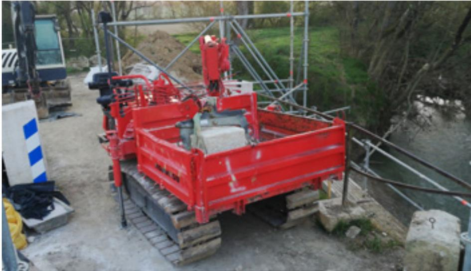
▲ Figure 14 - Engin de manutention des pierres avec bras auxiliaire et louve (pont sur le Gers à Aurenque, SGRP Maçonnerie Pierre de taille à Lectoure).
