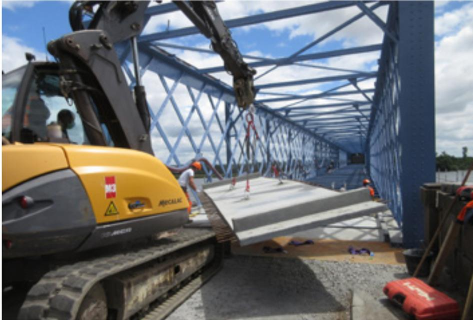
▲ Figure 36 - Des dalles préfabriquées en BFUP sont posées sur l'ouvrage pour reconstituer le hourdis du tablier (chantier du pont de Mauves-sur-Loire, entreprise Bouygues TP Régions France).
