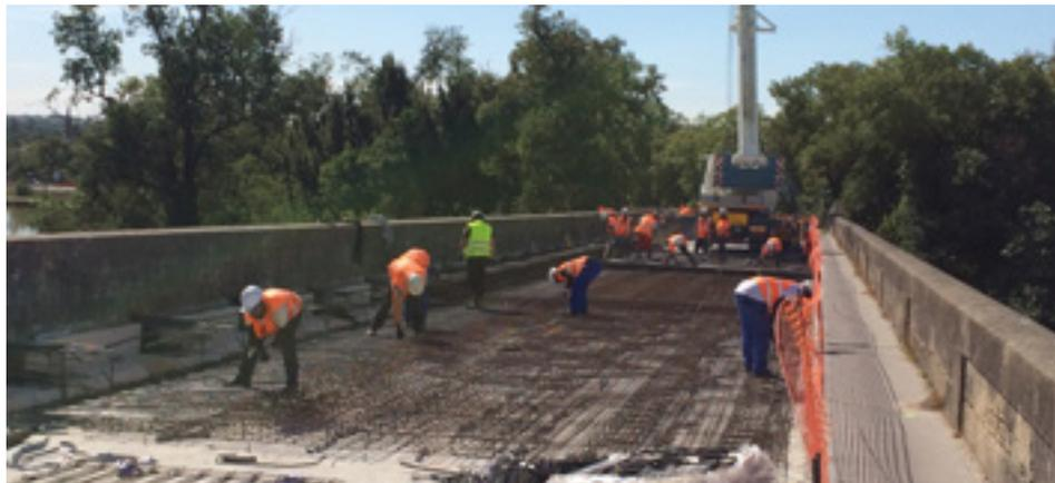
▲ Figure 11 - Coulage d'une dalle béton sur les voûtes. La dalle en béton armé permet d'ancrer une passerelle latérale métallique pour les piétons et cyclistes, tout en complétant l'étanchéité (pont de Cubzac-les-Ponts, NGE génie civil).
