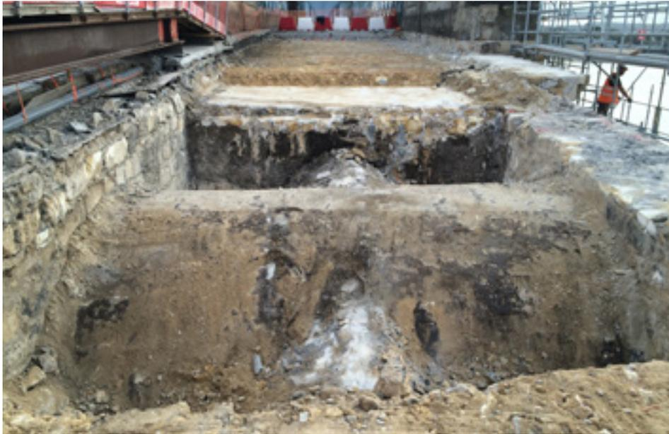
▲ Figure 3 - Mise à nu des voûtes (pont de Cubzac-les-Ponts, NGE génie civil). Un échafaudage latéral pallie le démontage des parapets.
