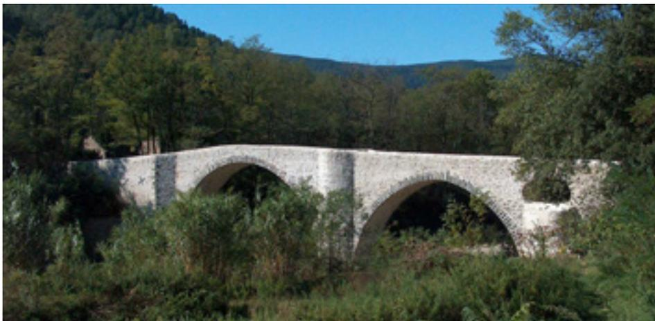
▲ Figure 15 - Rejointoiement complet du pont vieux de Mialet dit des Camisards sur le Gardon (30). On voit également à gauche les croix d'ancrage et les tirants (entreprise Cofex Méditerranée).
