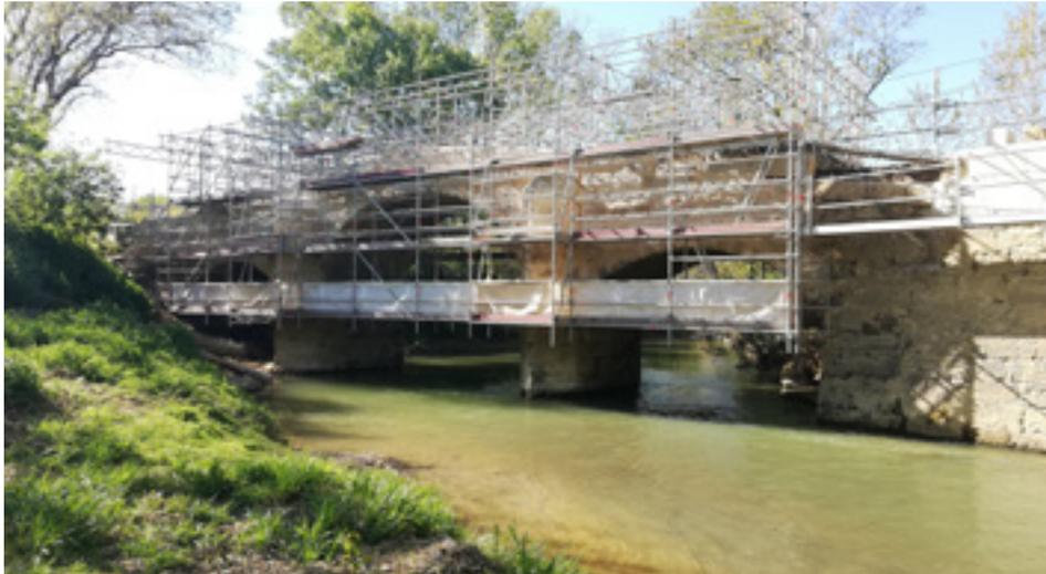
▲ Figure 18 - Échafaudage pour le changement de pierres et le ravalement (pont sur le Gers à Aurenque, SGRP maçonnerie pierre de taille à Lectoure).
