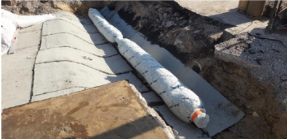
▲ Figure 6 - Mise en place d'un drain raccordé aux réseaux d'eaux pluviales pour évacuer les eaux du remblai. Une rambarde ou une signalisation serait nécessaire pour prévenir les chutes (pont Saint-Esprit à Bayonne, maîtrise d'œuvre Getec Sud-Ouest).
