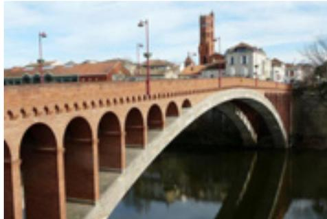
◀ Figure 47 - Le pont de Villeneuve-sur-Lot. Un arc double en béton armé supporte d'élégantes arches, également en béton, revêtues de briques (Eugène Freyssinet, 1923, portée 100 mètres).
