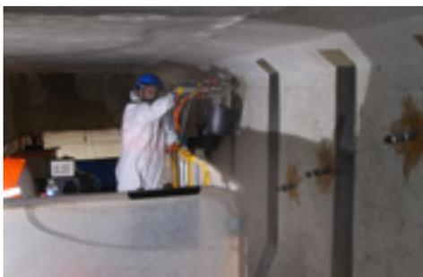
◀ Figure 79 - Réinjection de gaines présentant des défauts (VIPP 211 sur l'A7 à Chasse-sur-Rhône, entreprise Freyssinet).
