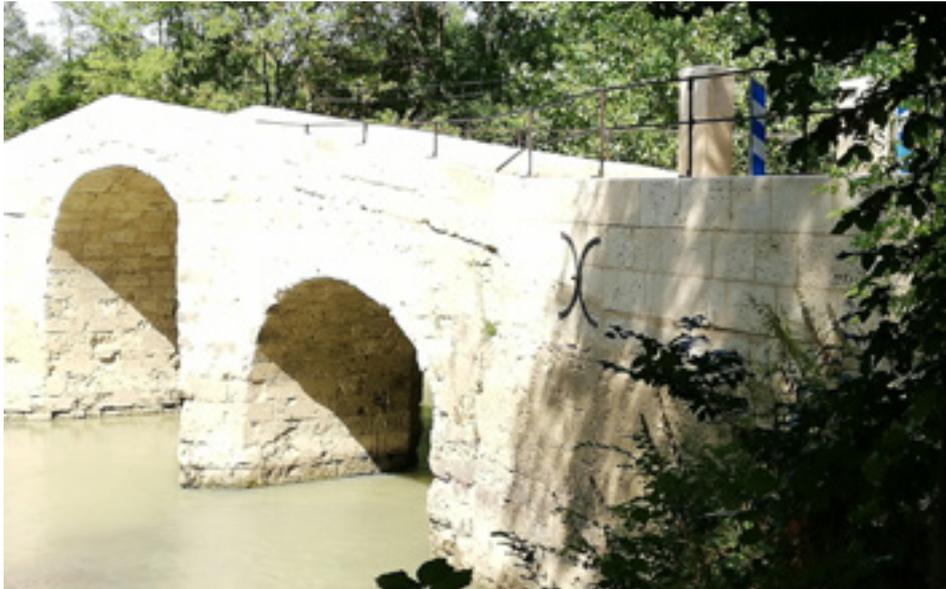
▲ Figure 16 - Le tirant et les croix d'ancrage ont été installés au niveau de la culée côté Aurenque (pont sur le Gers à Aurenque, SGRP Maçonnerie Pierre de taille à Lectoure).
