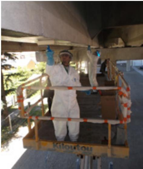
◀ Figure 76 - Collage de bandes en sous-face : gants, visière et combinaisons protègent la peau des opérateurs (VIPP 211 sur l'A7 à Chasse-sur-Rhône, entreprise Freyssinet).
