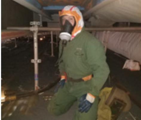
◀ Figure 46 - Protection individuelle pour le grenailage de peintures plombifères. Au sol, le heaume utilisé lors du grenailage (pont de Sèvres, entreprise Lassarat).
