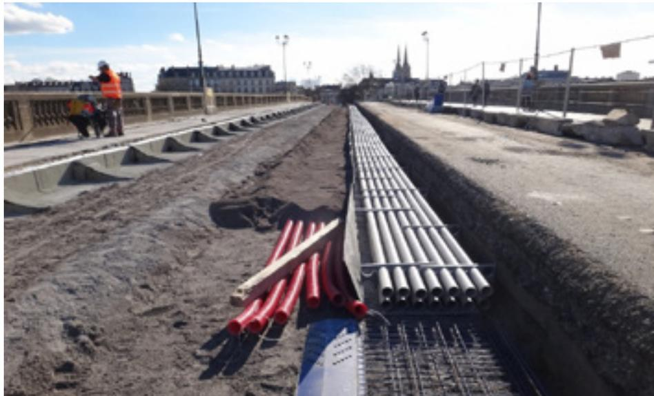
▲ Figure 21 - Des caniveaux destinés au passage de nouveaux réseaux sont installés dans le remblai (pont Saint-Esprit à Bayonne, maîtrise d'œuvre Getec Sud-Ouest).
