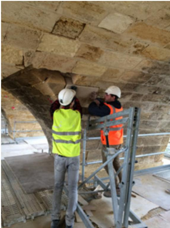
◀ Figure 13 - Affouillement de la maçonnerie pour changement de pierres défectueuses (pont de Cubzac-les-Ponts, Les compagnons de Saint-Jacques).
