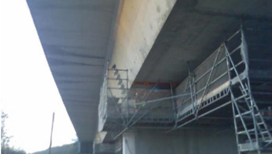
▲ Figure 60 - Accès sécurisé aux appareils d'appui et aux âmes du pont (pont sur l'Adour A63, entreprise Vinci).
