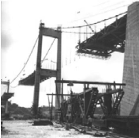
◀ Figure 24 - Un pont suspendu très connu, en construction (1960-1967) - le pont d'Aquitaine à Bordeaux. On remarque la culée d'ancrage, le câble porteur ainsi que les portions de tablier en cours de construction.
