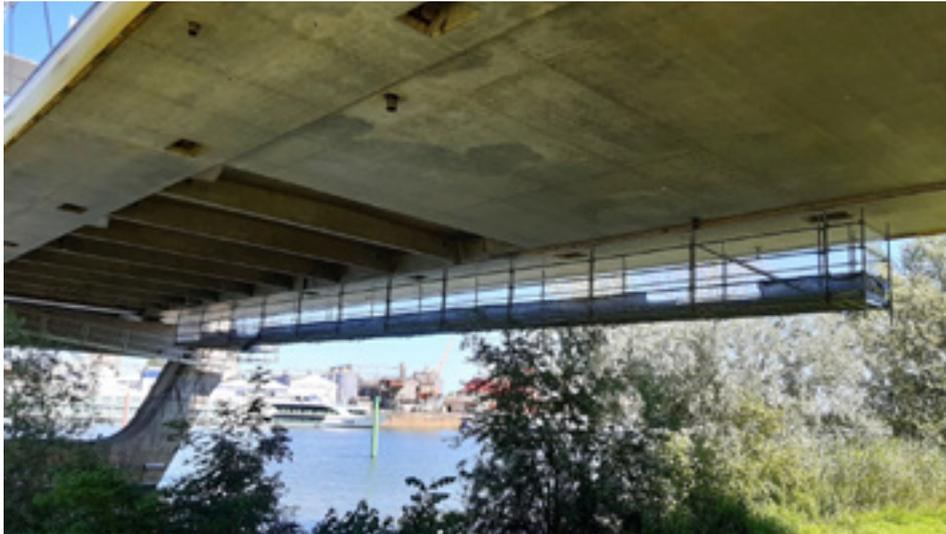
▲ Figure 38 - Une passerelle fixée sous le tablier donne l'accès à plusieurs ancrages bas sous le tablier (pont de Bourgogne à Chalon-sur-Saône, entreprise Freyssinet).
