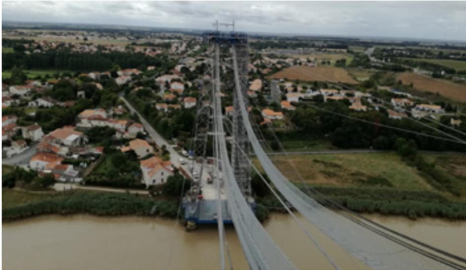
▲ Figure 42 - Passerelles type pont de singe permettant de traverser la Charente pour passer d'un pylône à l'autre (pont transbordeur du Martrou à Rochefort, entreprise Baudin Châteauneuf).
