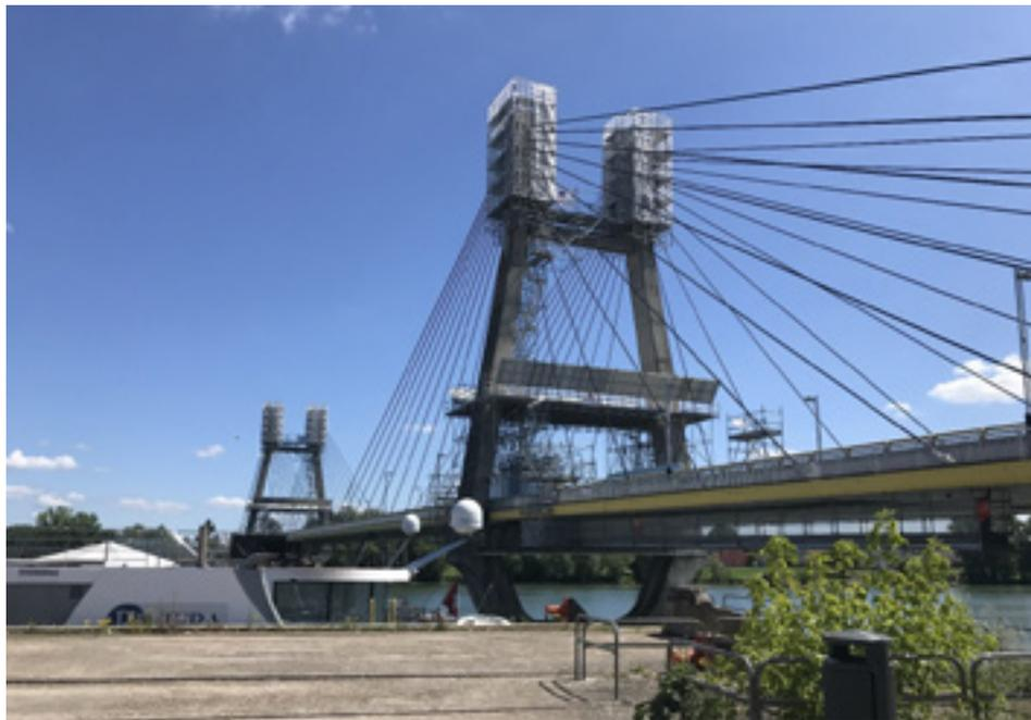
▲ Figure 40 - Un échafaudage donne accès aux attaches de haubans en tête de pylônes (pont de Bourgogne à Chalon-sur-Saône, entreprise Freyssinet).
