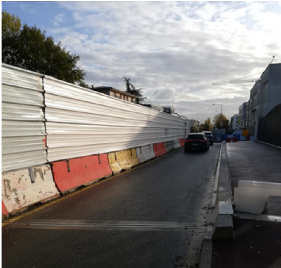
▲ Figure 55 - Le demi-tablier circulé est doté de glissières en béton armé, surmontées d'une palissade opaque (pont de Châtenay-Malabry, bureau d'étude SCE, entreprise Gagnereau).
