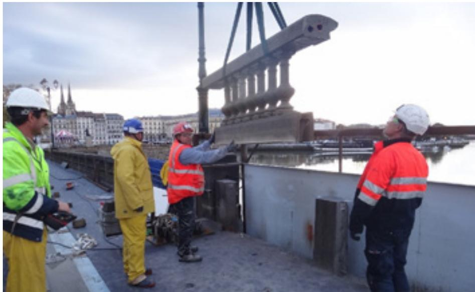
▲ Figure 22 - Changement de rambardes en béton. Un système astucieux de garde-corps provisoire protège contre les chutes à l'eau (pont Saint-Esprit à Bayonne, maîtrise d'œuvre Getec Sud-Ouest).
