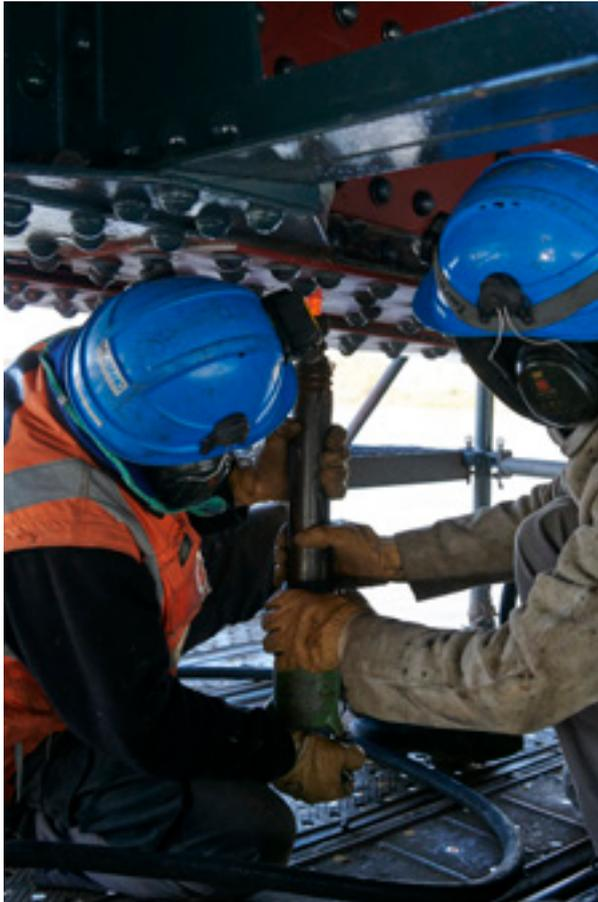
◀ Figure 30 - Pose de rivets à chaud. On remarque les gants et vêtements de cuir et la protection oculaire (pont ferroviaire de Pirmil à Nantes, entreprises Dumanois et Baudin Châteauneuf).
