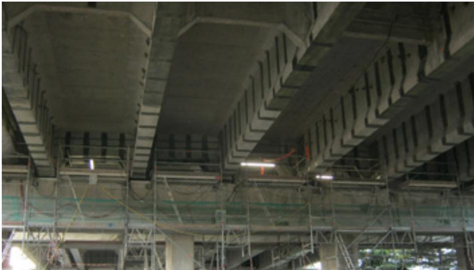
▲ Figure 74 - Travail en hauteur : échafaudage de pied sur les chevêtres d'appui, PEMP à ciseaux dans les travées (VIPP 211 sur l'A7 à Chasse-sur-Rhône, entreprise Freyssinet).
