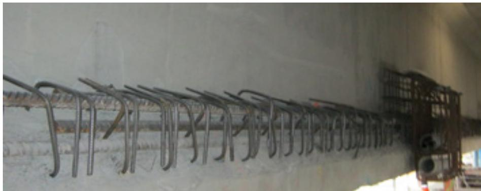
▲ Figure 72 - Les cadres pour le renfort des talons de poutres sont scellés à l'aide de résine époxy (pont de Saint-Nazaire, entreprise Bouygues).
