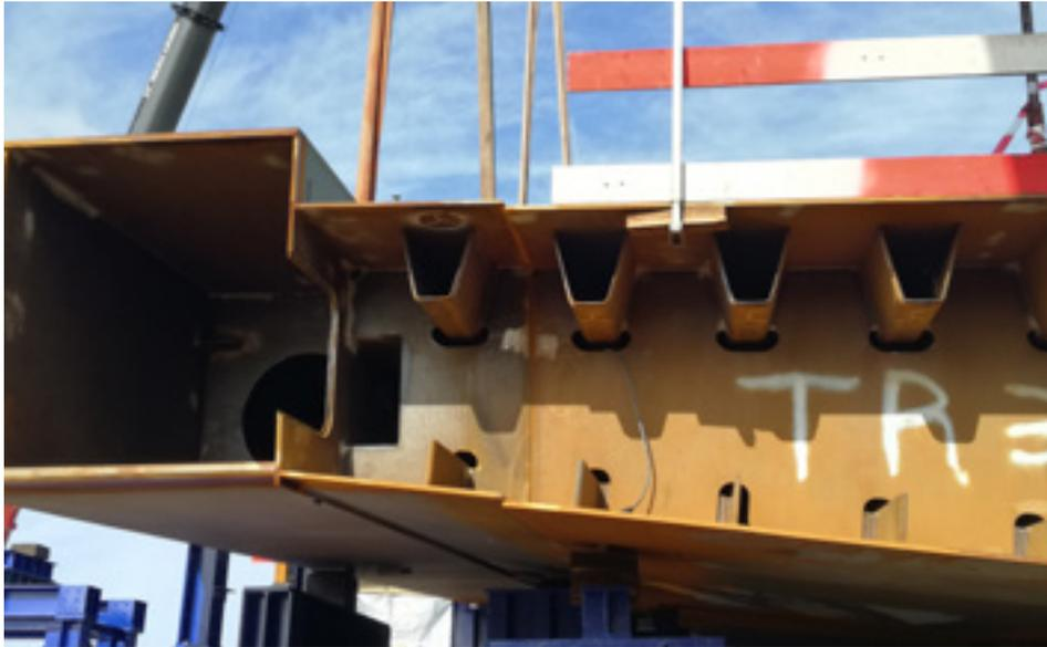
▲ Figure 27 - Le pont de la Palombe à Bordeaux est constitué d'un caisson mince avec une dalle orthotrope. On voit bien ici les augets de raidissement de la tôle qui va supporter le trafic routier (entreprise Bouygues).
