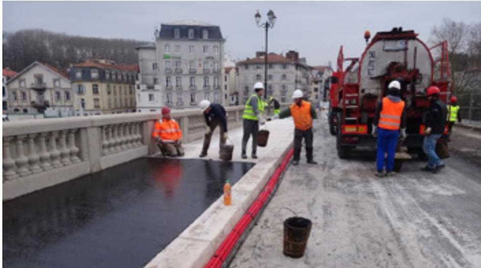
▲ Figure 5 - Finition de l'étanchéité des trottoirs par asphalte coulé à chaud (pont Saint-Esprit à Bayonne, maîtrise d'œuvre Getec Sud-Ouest).
