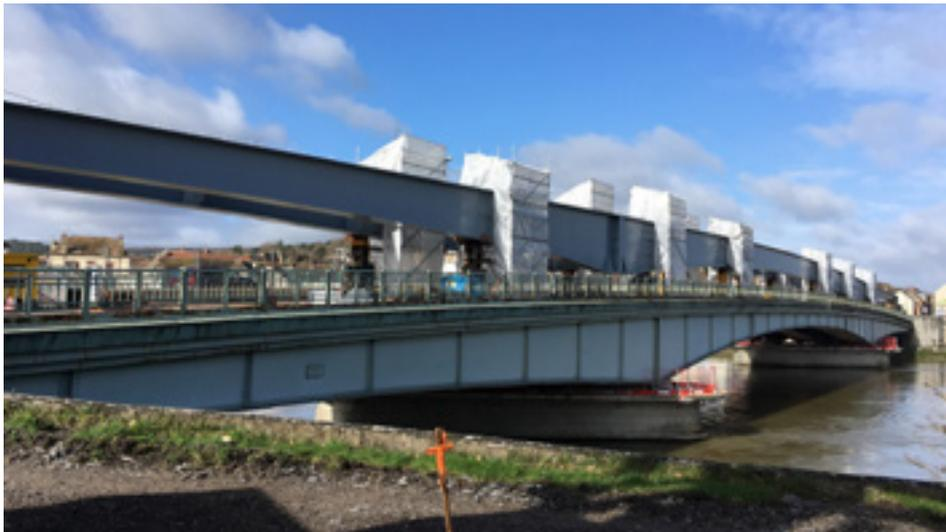
▲ Figure 26 - À Pont-sur-Yonne, les tronçons de charpente en PRS sont en cours d'assemblage par soudure (on peut voir les tentes de soudage). On complète ensuite la charpente par un hourdis béton (entreprises Vinci Construction France TP Lyon et Berthold).
