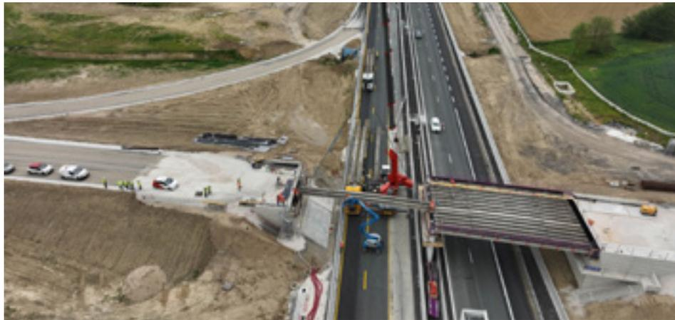
▲ Figure 49 - Construction d'un pont à poutres préfabriquées PRAD (entreprise Vinci, échangeur Agen Ouest, pose de poutres. Crédit Perivision).
