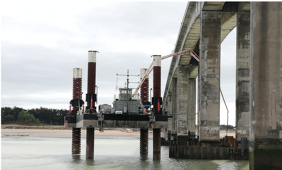
▲ Figure 69 - Bétonnage depuis la barge auto-élevatrice Cézembre. Le béton est acheminé par pompage depuis le tablier du pont (pont de Noirmoutier, entreprise Charier Génie Civil).
