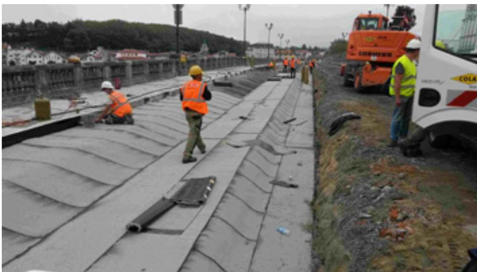
▲ Figure 4 - Étanchéité par feuilles bitumées (pont Saint-Esprit à Bayonne, maîtrise d'œuvre Getec Sud-Ouest).
