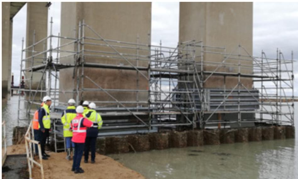
▲ Figure 68 - Pose des parements en résine époxy armée de fibre de verre à la base des piles (pont de Noirmoutier, entreprise Freyssinet).
