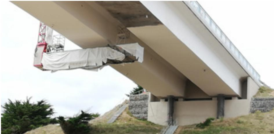
▲ Figure 66 - Application d'une peinture en sous-face de tablier à l'aide d'une nacelle négative (pont de Noirmoutier, entreprise Freyssinet).
