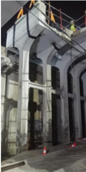
Les piles constituant les appuis, de part et d'autre du tablier, doivent également être démolies lors d'une intervention de nuit. Après avoir découpé et retiré les éléments de tablier adjacents, un ensemble constitué d'un tronçon de tablier et des deux poteaux correspondants est élingué et maintenu le temps du sciage de la base des piles. Il est ensuite évacué par levage à l'aide de la grue mobile.
