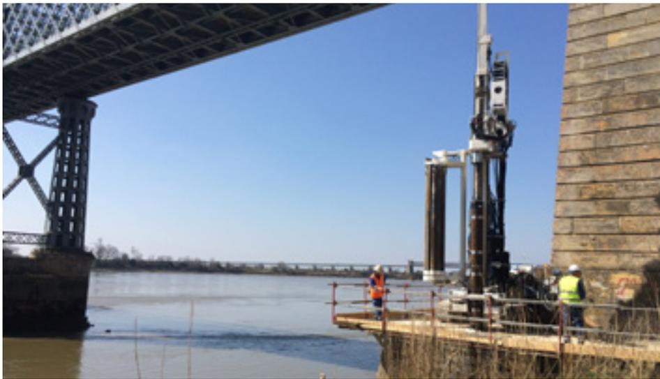
▲ Figure 8 - Forage de micropieux pour renforcer une culée (pont de Cubzac-les-Ponts, NGE Génie civil).
