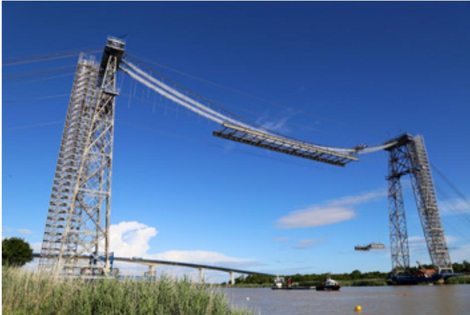
▲ Figure 34 - Chargement d'un tronçon de tablier sur une barge (pont transbordeur du Martrou à Rochefort, entreprise Baudin Châteauneuf).
