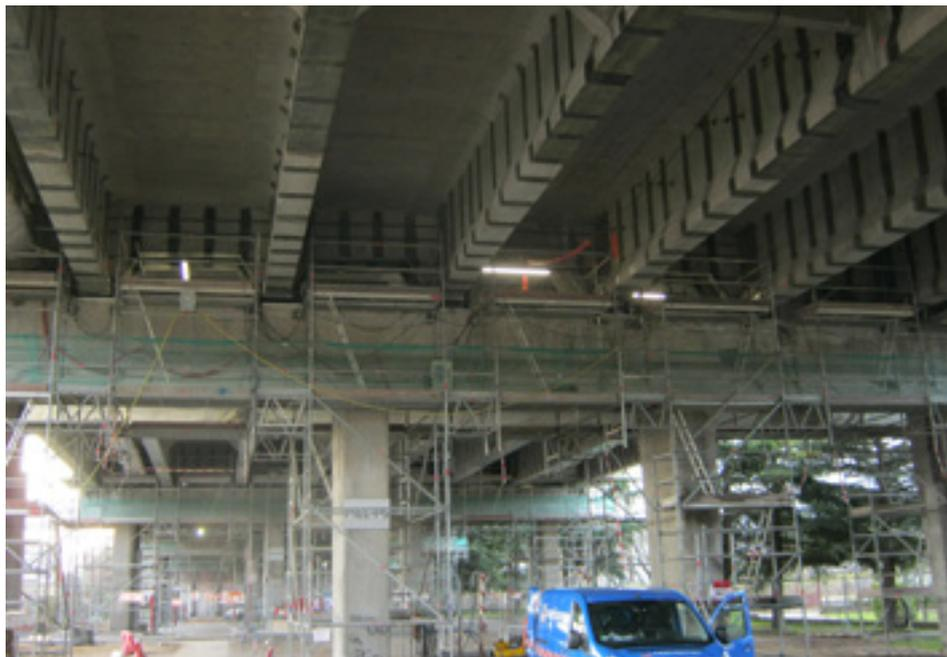
▲ Figure 48 - Vue des poutres VIPP sur le viaduc de Chasse-sur-Loire sur l'A7 en cours de réparation (entreprise Freyssinet).
