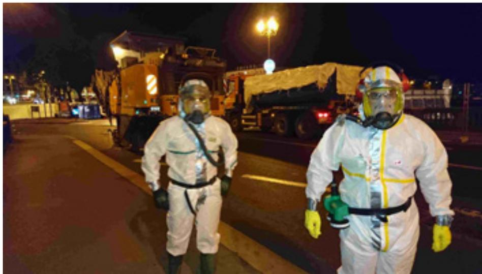
▲ Figure 2 - Protection lors du rabotage des enrobés du fait de la présence d'amiante détectée lors du diagnostic (pont Saint-Esprit à Bayonne, maîtrise d'œuvre Getec Sud-Ouest).
