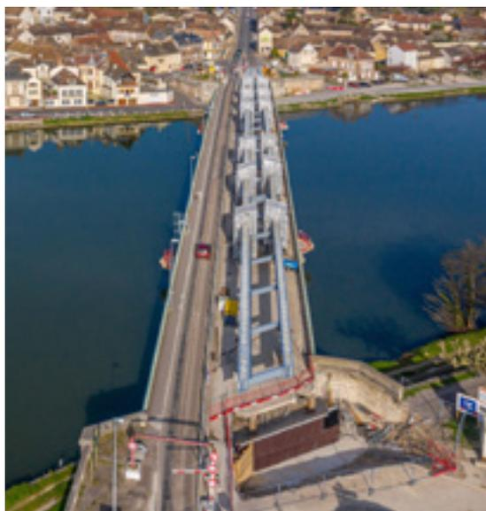
◀ Figure 28 - Sur le chantier de Pont-sur-Yonne, la charpente neuve a été assemblée par soudure sur l'ancien tablier. On peut voir les tentes de soudeurs à la jonction des poutres (entreprises Vinci Construction France TP Lyon et Berthold).
