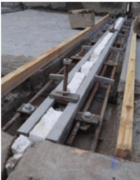
◀ Figure 17 - Changement du joint de chaussée (pont Saint-Esprit à Bayonne, maîtrise d'œuvre Getec Sud-Ouest).
