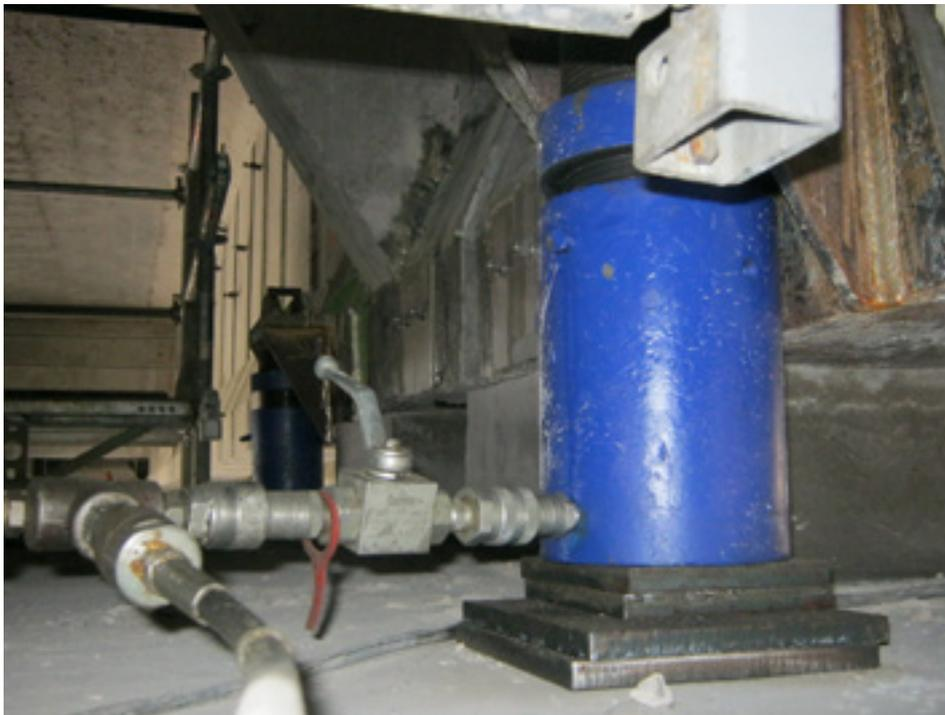
▲ Figure 78 - Vérinage des poutres (Freyssinet VIPP 211 sur l'A7 à Chasse-sur-Rhône).
