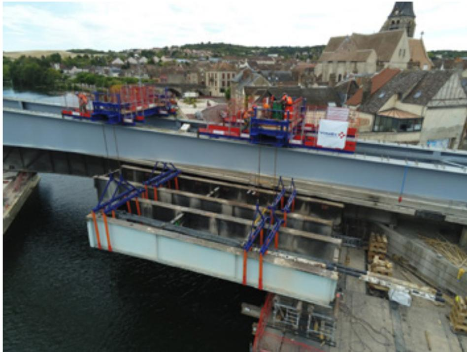
▲ Figure 33 - Les tronçons de charpente arrivent sur un quai provisoire. Chantier de Pont-sur-Yonne (entreprises Vinci Construction France TP Lyon et Berthold).
