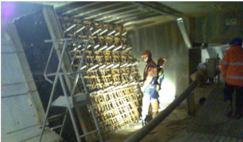
▲ Figure 61 - Bossage déviateur en cours de ferrailage (pont sur l'Adour A63, entreprise Vinci).
