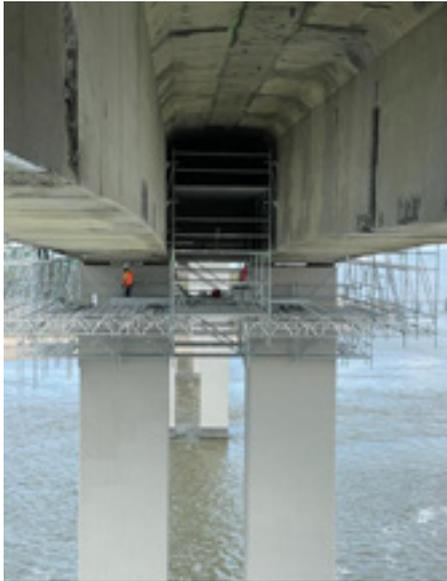
◀ Figure 20 - Vue d'un échafaudage suspendu en sous-face (pont de Noirmoutier, entreprise ATS)
