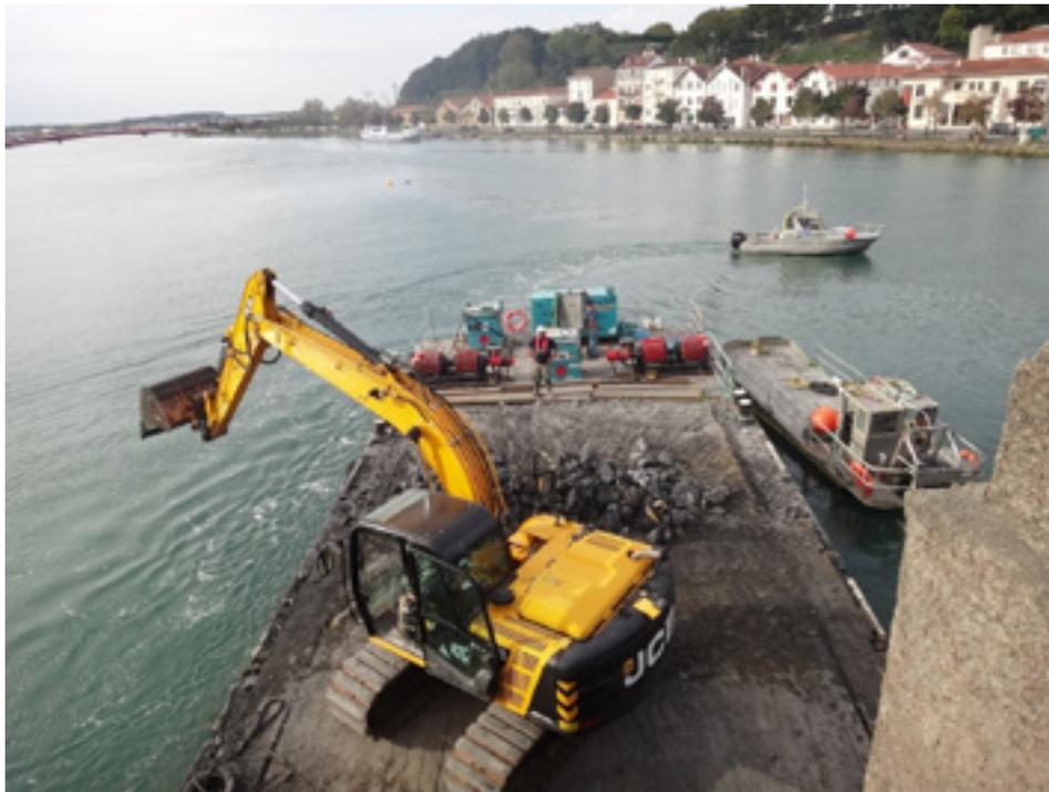
▲ Figure 7 - Pose d'enrochements à l'aide d'une pelle sur barge (pont Saint-Esprit à Bayonne, maîtrise d'œuvre Getec Sud-Ouest).
