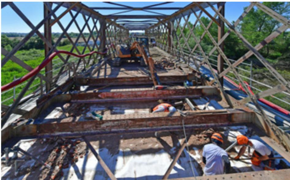
▲ Figure 32 - Sur le chantier du pont de Mauves-sur-Loire, une équipe est en train de retirer les voûtaines en maçonnerie du tablier protégé par un platelage complet (entreprise Bouygues TP Régions France. Photo ©Willy Berré).
