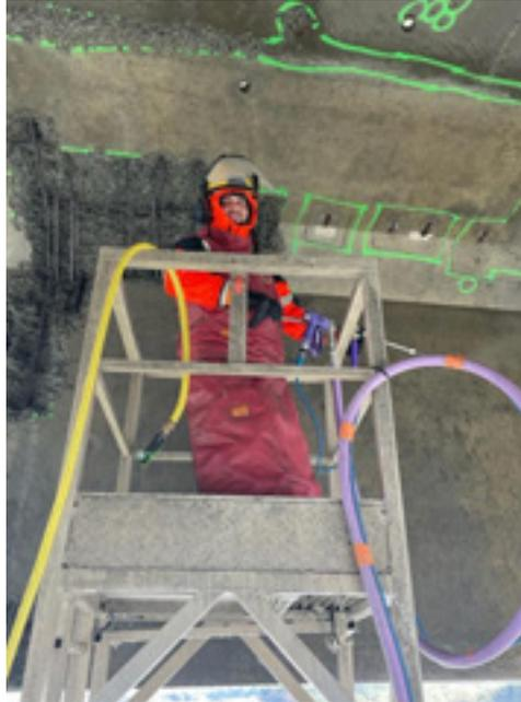
◀ Figure 67 - Le détournage des aciers est ici réalisé ici par hydrodémolition sur un échafaudage (pont de Noirmoutier, entreprise ATS).
