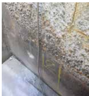
Altération du béton en zone émergée (en haut), alors que le béton de la zone immergée (en bas) apparaît sain.
