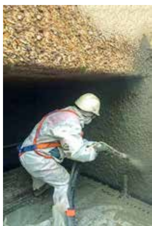
Réhabilitation d'un réseau d'assainissement par projection de béton.
