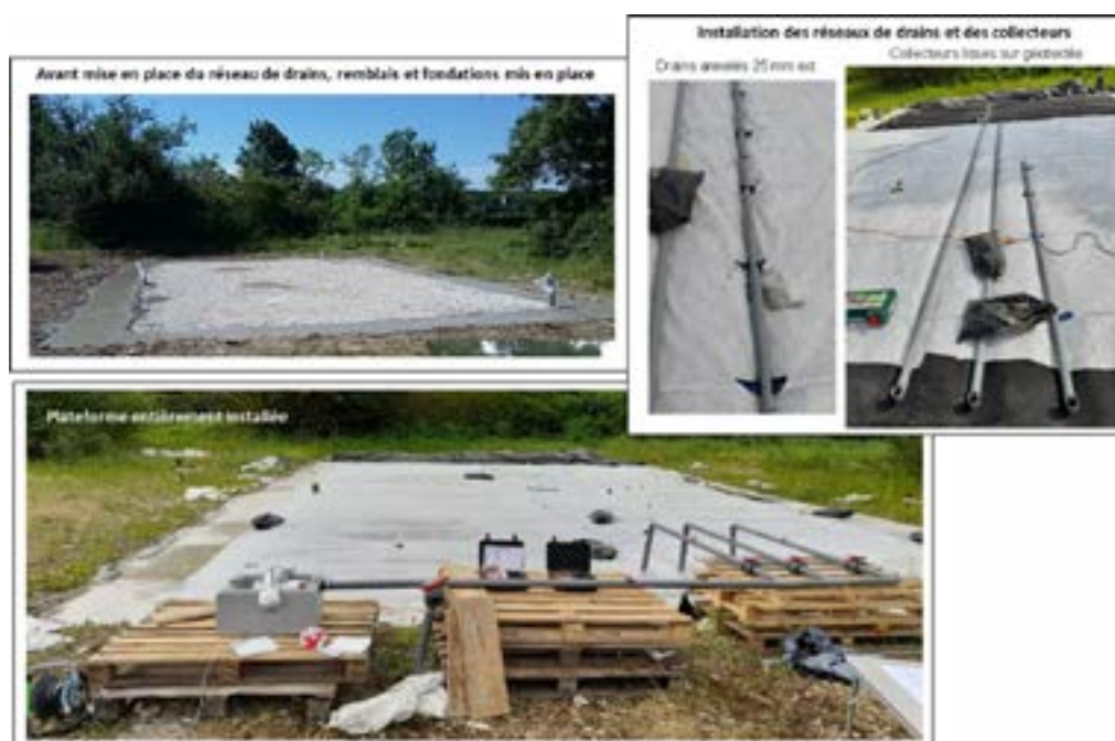
Mise en place de la plateforme expérimentale.
