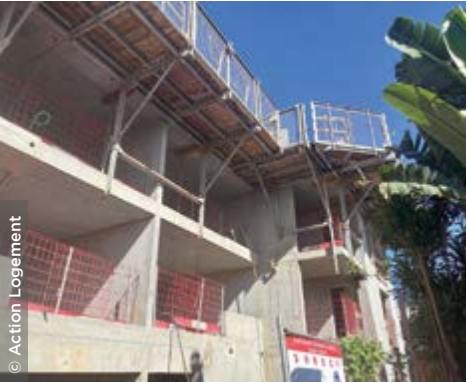
À Kawéni, résidence pour jeunes en cours de construction ( AL'MA ).
