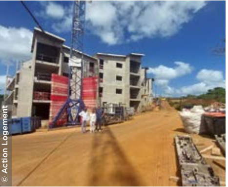
À Chirongui, la résidence Souimanga en cours de construction ( AL'MA ).
