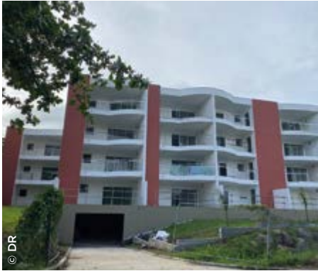
En Martinique, à Fort-de-France, la nouvelle résidence livrée par Foncière Logement.
