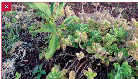
*Développement d'une jeune pousse d'arbre d'avocatier marron dont les racines risquent rapidement de dégrader le dispositif d'étanchéité à l'eau de la toiture. © AQC*
