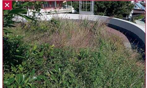
Absence de protection collective de type garde-corps et point d'ancrage isolé sans ligne de vie et peu visible dans la végétation. © AQC
