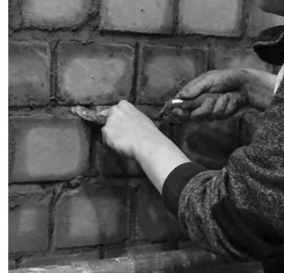
**12.** Tracer proprement les joints quand le mortier est encore frais et malléable pour un jointoiment immédiat
