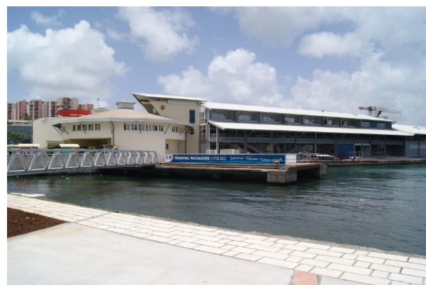
Figure 94 Photographie de la gare inter-îles du quai Ouest (Source : Grand Port Maritime de la Martinique)
