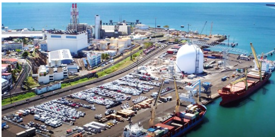
Figure 92 Photographie du secteur Est de l’Hydrobase (Source : Grand Port Maritime de la Martinique)
