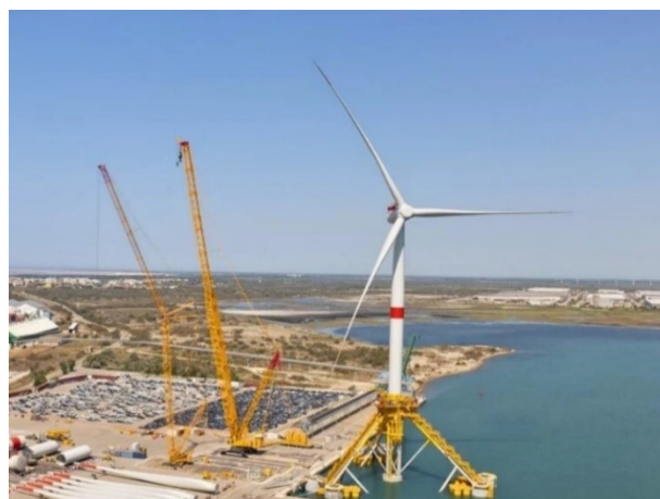
Figure 82 Intégration de la turbine sur le flotteur - ferme pilote Provence Grand Large (Source EDF Renouvelables)
