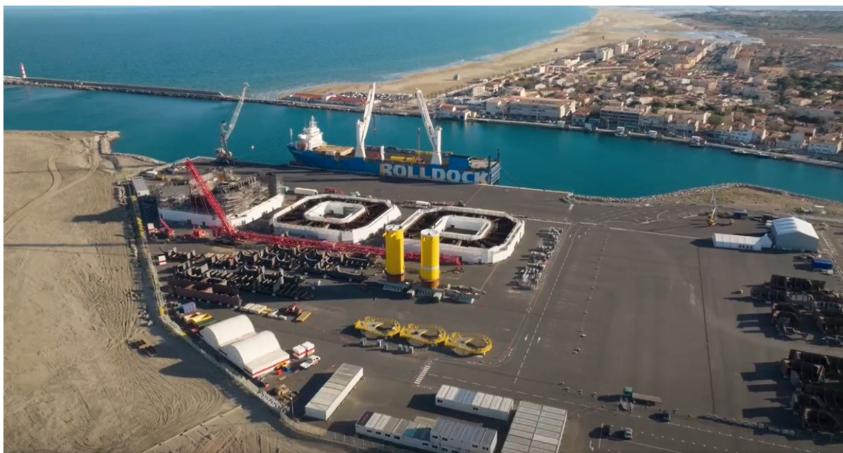
Figure 84 Flotteurs d'éoliennes en béton en cours de construction à Port-la-Nouvelle (Source – Euroports)
