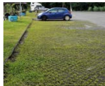
Parking en dalles alvéolaires enherbées à Montsinéry
