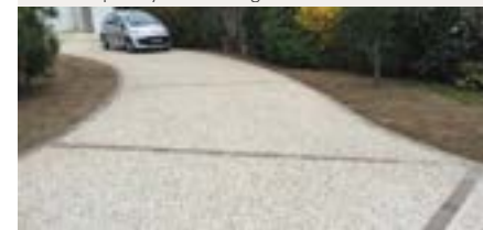
Voie carrossable en béton clair © Pavex
