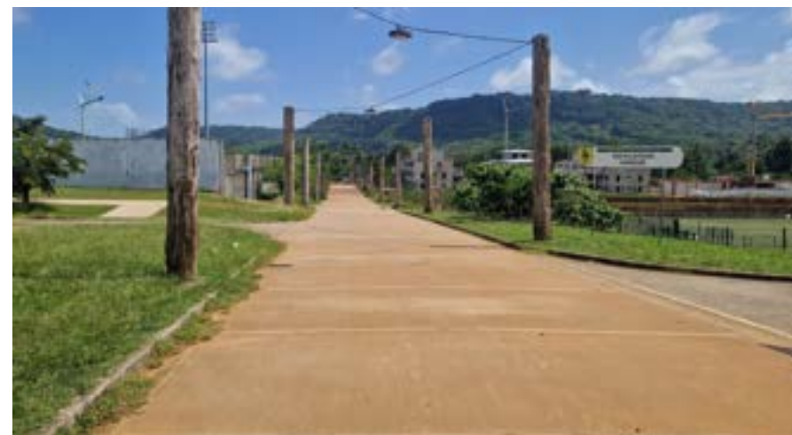
Voiries de l'écoquartier G. Othilly à Rémyre-Montjoly - Réutilisation de la terre du site pour les revêtements de sol
