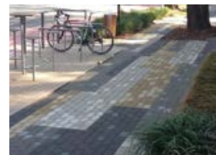
Trottoir en pavés drainants à São Paulo © OICS
