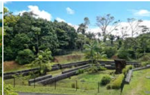
Bassin de rétention paysagé, Centre de tri, R-Montjoly © Aquaa
