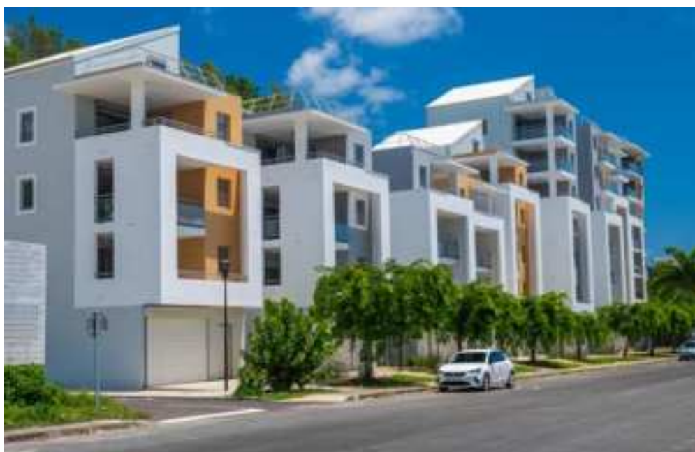
› Res Les voiles du Mémorial - Pointe à Pitre - 34 logements
